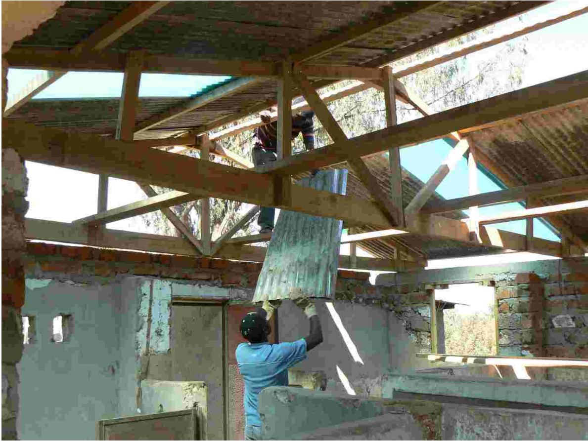
Ausbau des Schweinestalls
