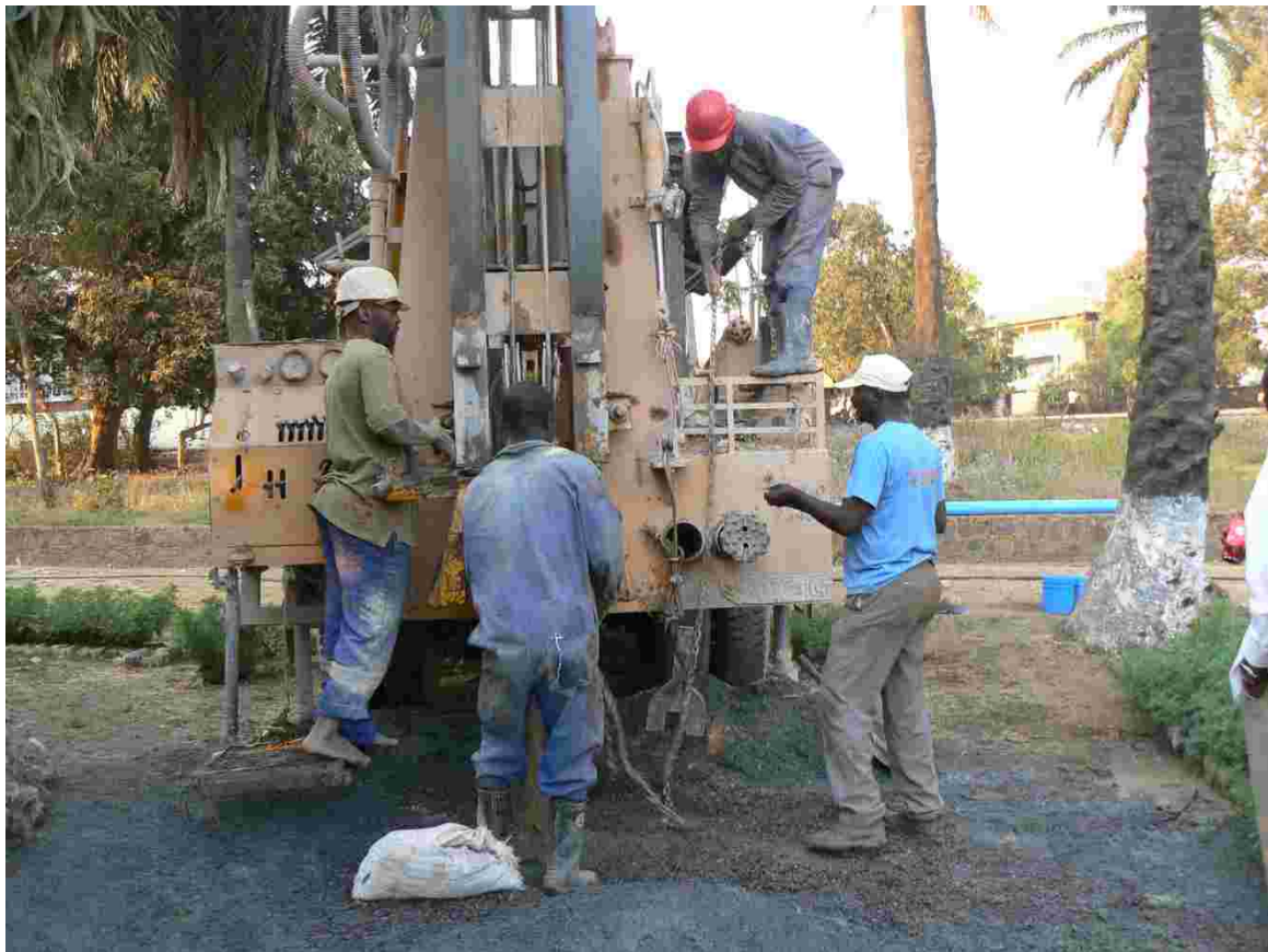
Brunnenbohrung am 11. Juli 2013
