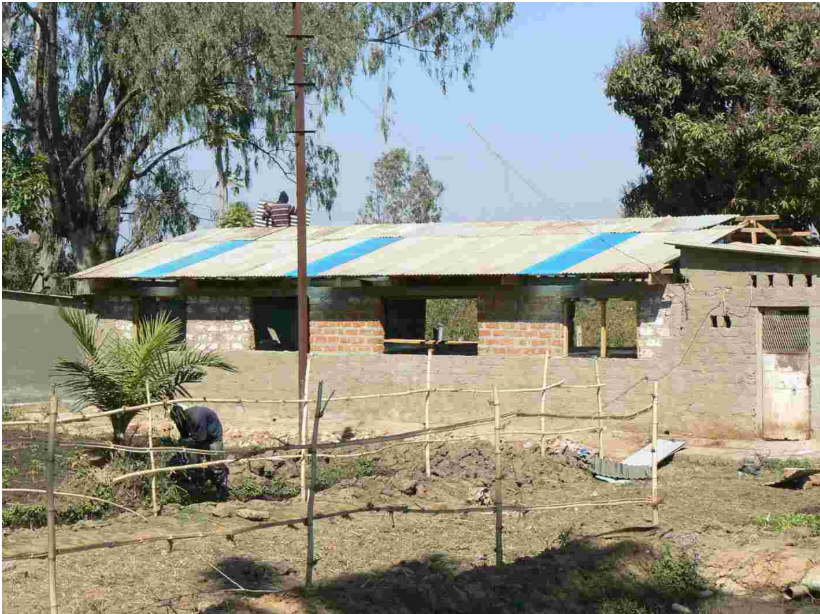
Ausbau des Schweinestalls (Seitenansicht)
