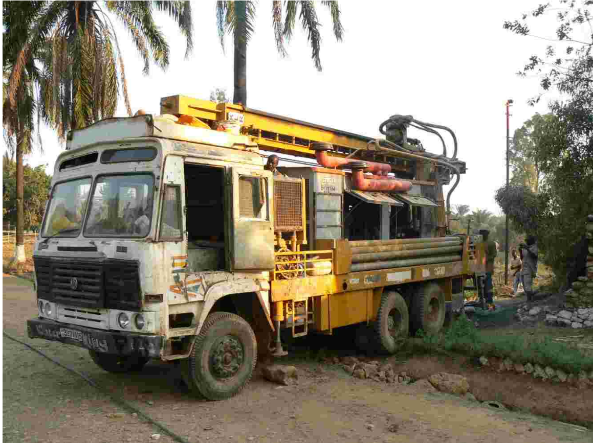
Brunnenbohrung am 11. Juli 2013
